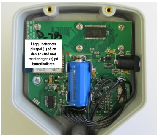
Bild 9. Byte av batteri
